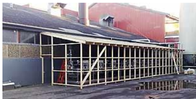
FIGUR 2: IMPLEMENTERING AF PILOTANLÆG I BYGNING UNDER KLARGØRING.
